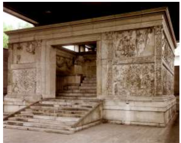
Олтарът на мира - Западна фасада
